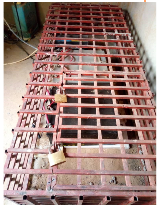
les batteries solaires protégées
