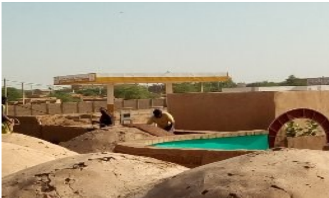
Le toit du centre artisanal féminin en cours de renforcement
